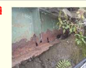
<主桁腐食> 国道165号(吸原橋)
